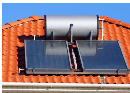
Eguzki-energia termikoa Solar térmica
