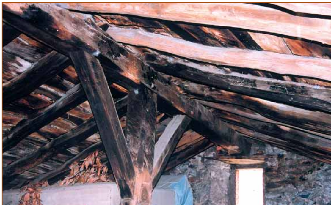
Teillatu-egitura eta zutikoa
