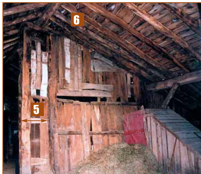
4- Telaituraino doazen dolarearen berniak 5- Berniaren xehetasuna erregulazio-zuloekin 6- Gailurreko habea
