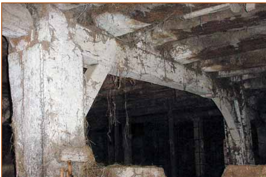
Lehen solairua eusten duen egitura ukuilutik ikusita
